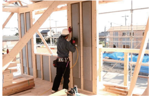
物林が展開するソルツの現場施工の風景。最短1日、長くても2日でフレーミング工事が完了する
